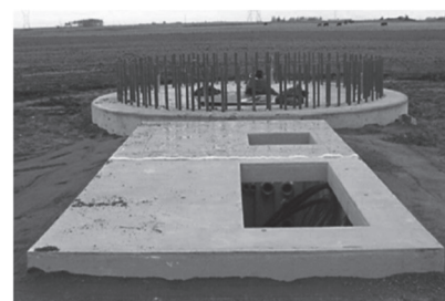
Fundamenty pod turbinę wiatrową Foundations of wind power unit
